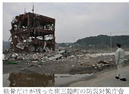
鉄骨だけが残った南三陸町の防災対策庁舎
